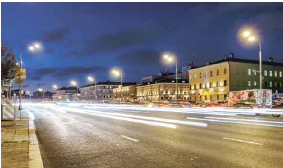
Садовое кольцо г. Москва
