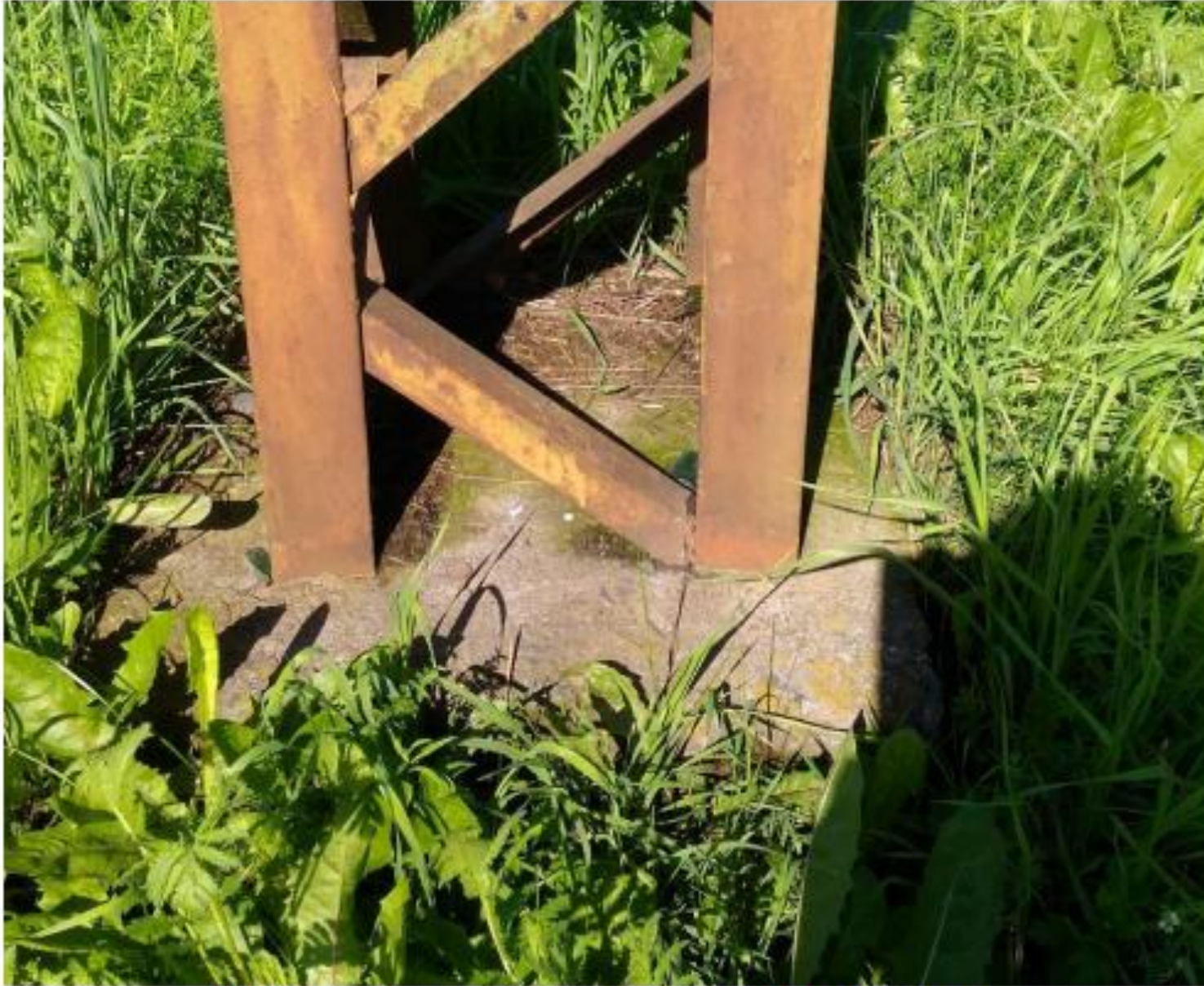
Образец опоры без заземляющих устройств.
