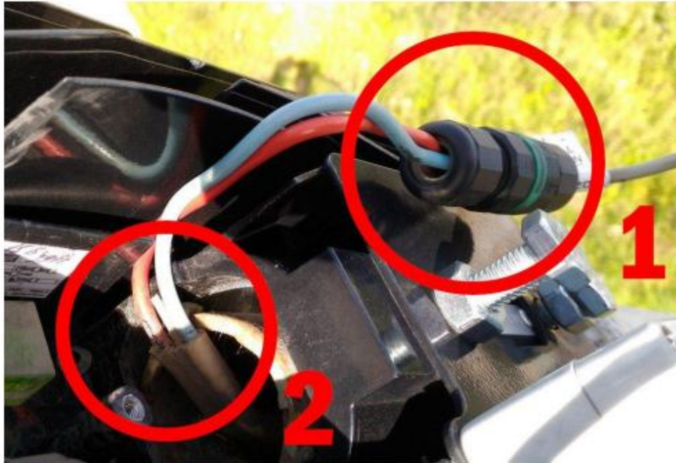
Отсутствие заземления: 1 - заземляющий проводник отсутствует, отсутствует герметизирующая прокладка в соединителе; 2 – заземляющий проводник откушен на вводе в светильник.
