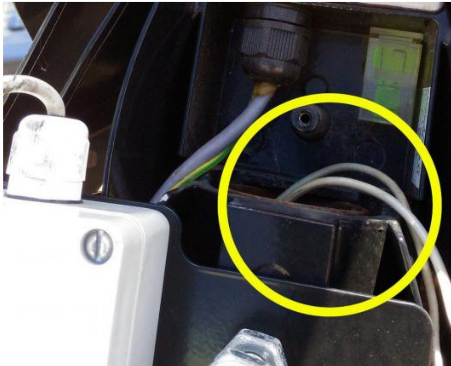
Отсутствие заземления: заземляющий проводник отсутствует, монтаж выполнен проводом для временного подключения местного освещения с однослойной изоляцией.
