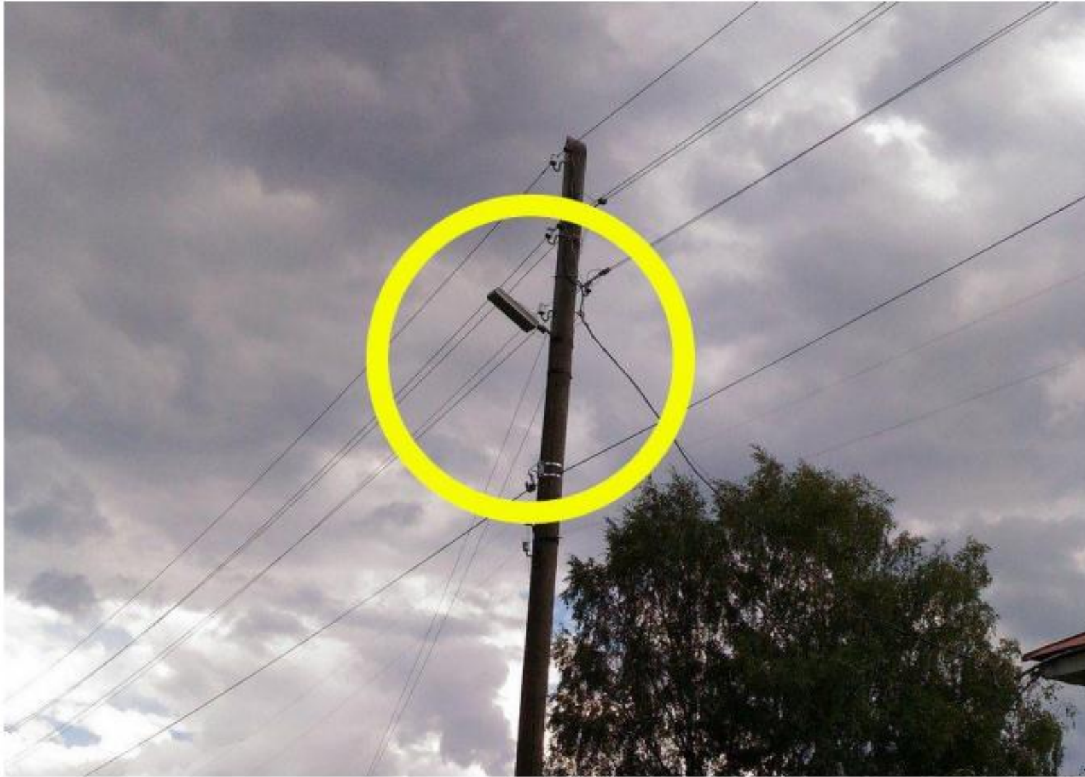
Отсутствие заземления: светильник смонтирован на деревянную опору
