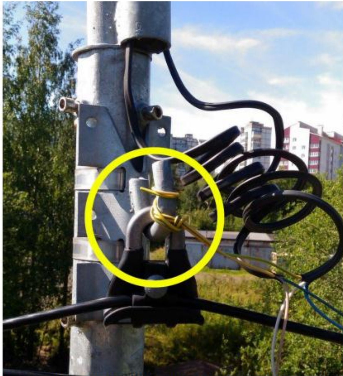
Отсутствие заземления: откушенный заземляющий проводник намотан на крюк опоры
