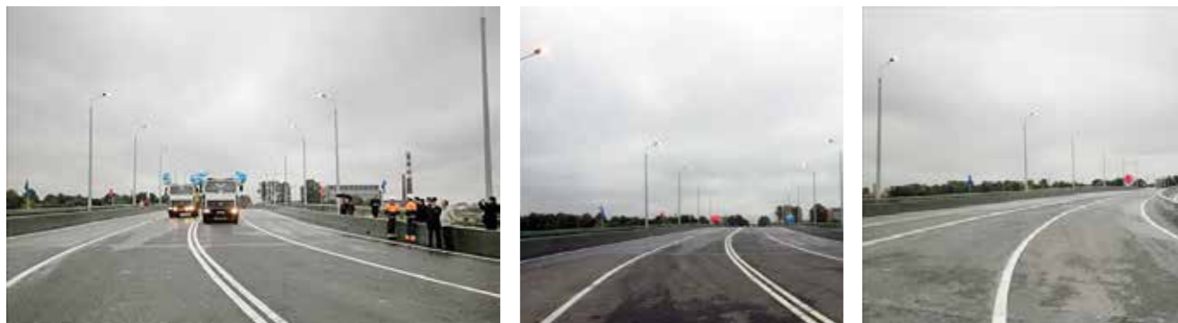
г. Санкт-Петербург, Большой Петровский мост
